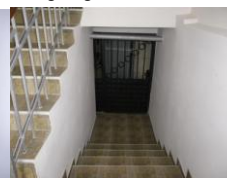
Toegang tot kelder
