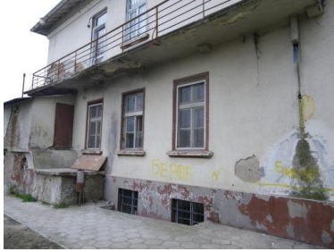
Op de plaats van linker raam komt nieuwe zij-ingang
