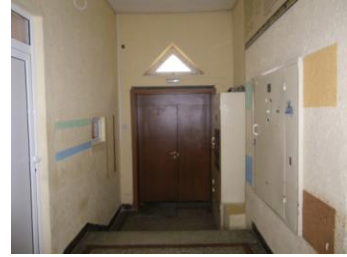
Hoofdingang wordt gerenoveerd.
